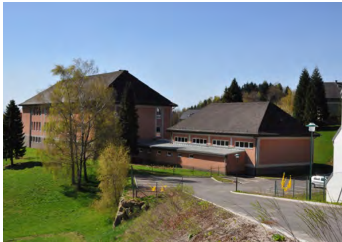
Das umgebaute erweiterte Schulhaus von 1987.
